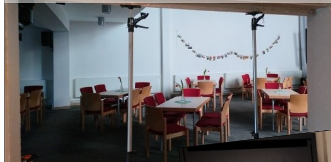
Vorbereitungen für die geplante Schiebetür
