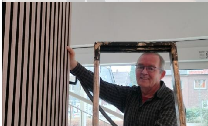
... und kurz vor der Vollendung der Verkleidung
